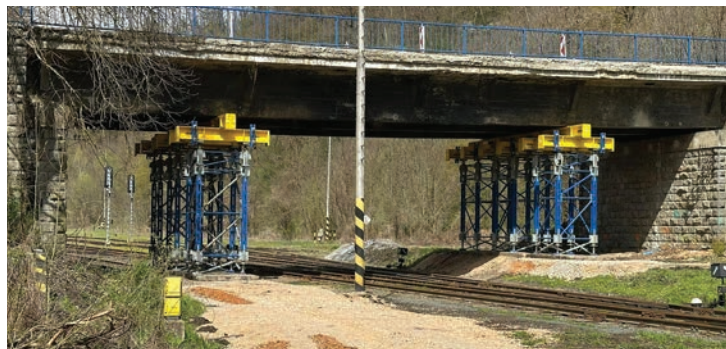
Nasazení podpěrného systému Doka Unikit (UniKit podpěrná věž 480 a UniKit nosníky) při rekonstrukci slovenského mostu v havarijním stavu.
