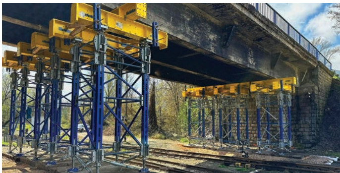
Nasazení podpěrného systému Doka Unikit (UniKit podpěrná věž 480 a UniKit nosníky) při rekonstrukci slovenského mostu v havarijním stavu.
