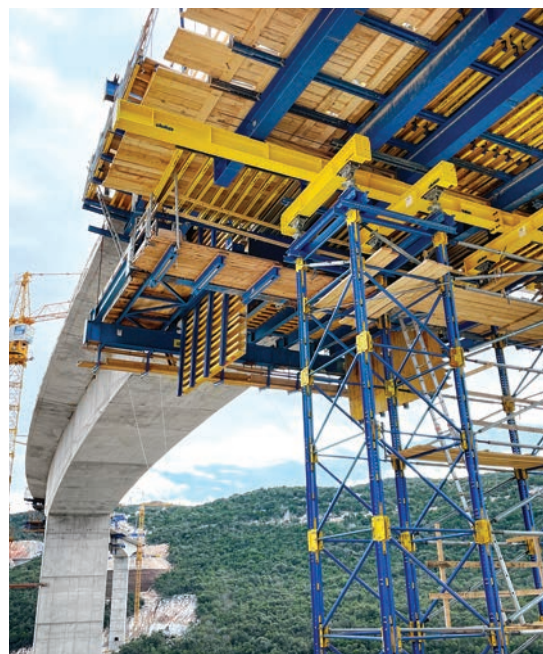
Realizace mostu Dumanja Jaruga v Chorvatsku
