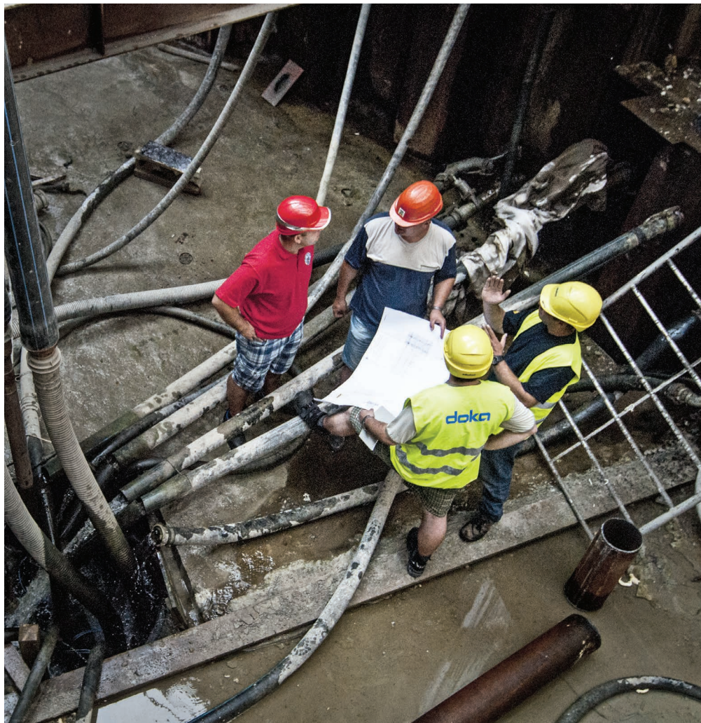
▲ Technik Petr Vosyka a montážní mistr Petr Voňavka z pražské pobočky Česká Doka konzultují nasazení bednění pro extrémní projekt - podvodní betonáž malé vodní elektrárny Liběchov.
