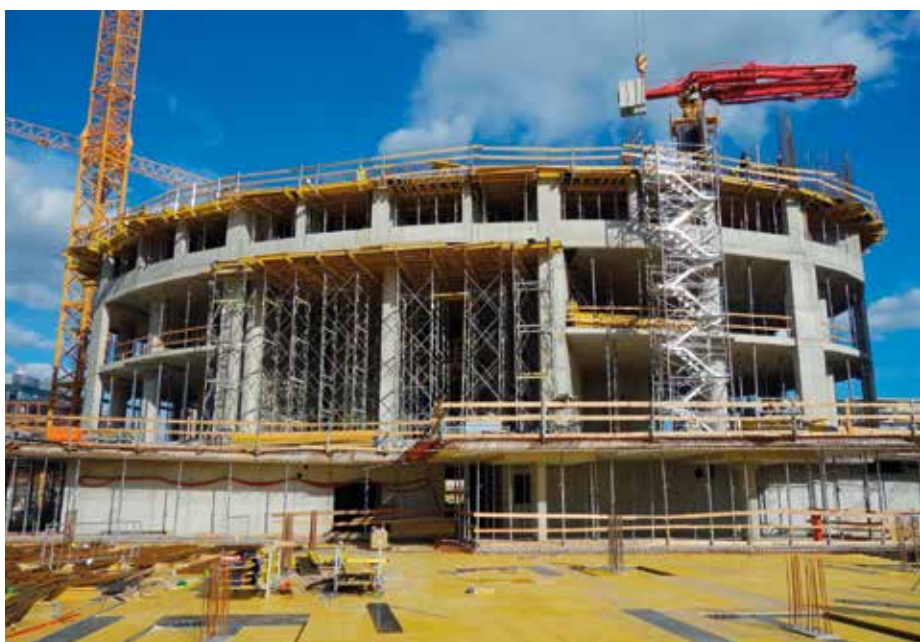
▲ Pohľad na výškovú časť budovy so zadebnými stropmi flexibilným systémom Dokaflex a podpornými vežami Staxo 40. Napravo sa nachádza schodisková veža umožňujúca bezpečný výstup na pracovisko.
