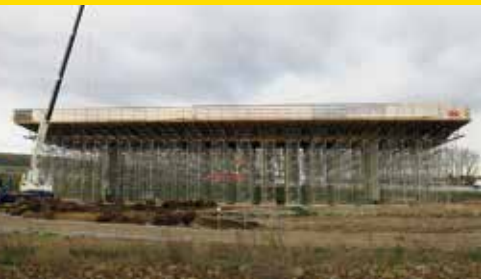
▲ Pozdĺžny pohľad na mostnú konštrukciu.
