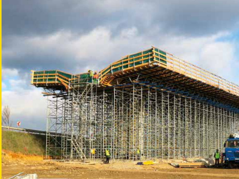
▲ Pohľad na zadenbenú mostnú konštrukciu; použité debniace systémy: podperný systém Staxo 100 a nosníkové debnenie TOP 50.
