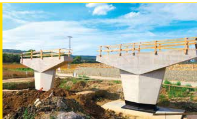
▲ Reálna podoba pilierov zrealizovaných s debnením Doka, ktoré bolo predmontované v Doka-servise predmontáže v Bratislave.
