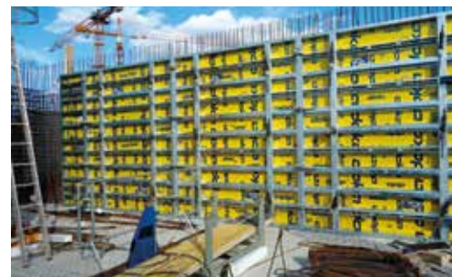
▲ Nový rámový systém Framax Xlife plus s panelmi rozmerov 2,7 x 3,3 m.
