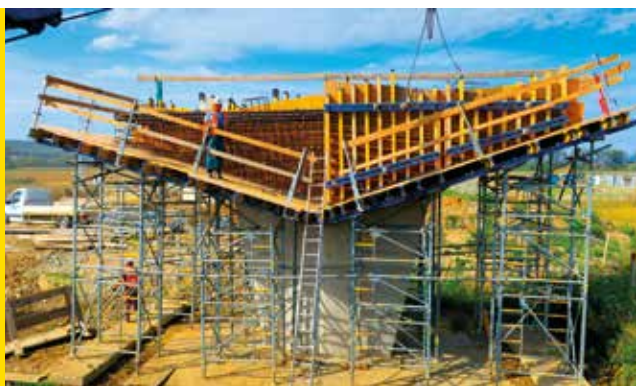
▲ Montáž hlavice piliera – nosníkové debnenie Top 50 s drevenými ramenátmi podopreté podperným systémom Staxo 100.
