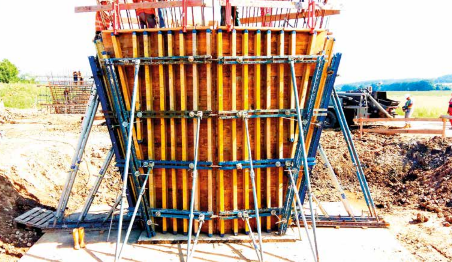
▲ Realizácia drieku piliera pomocou nosníkového debnenia Top 50 a jeho výsledný tvar po oddebení.
