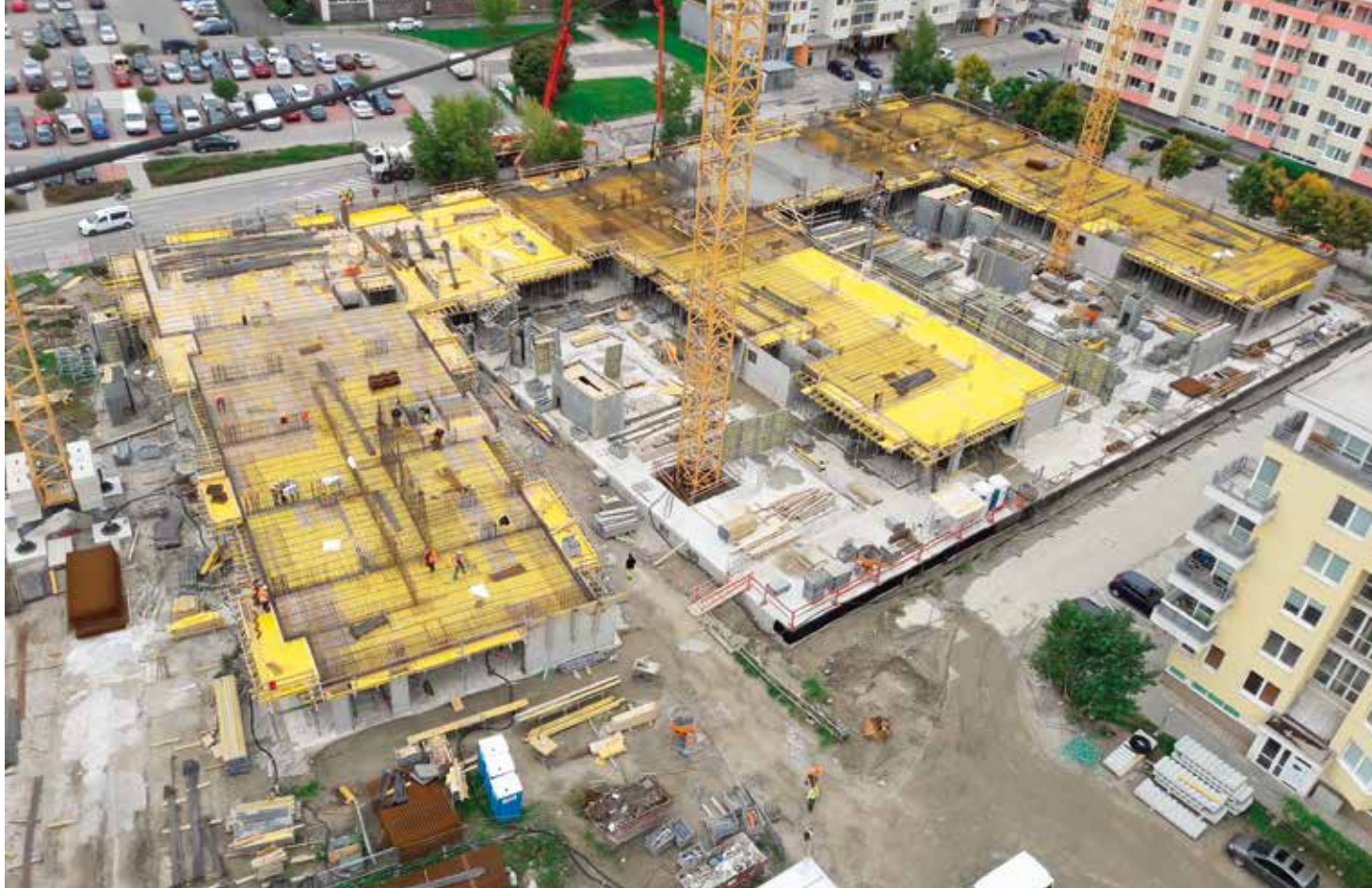
▲ Pohľad na rozostavaný objekt Avidol
