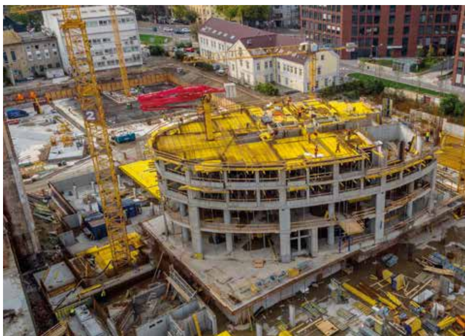
▲ Pohľad na prebiehajúce debniace práce na stropnej konštrukcii 4. NP z celkového počtu 31 podlaží.
