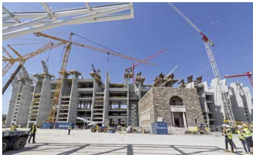
▲ Pôvodný štadión, vybudovaný v roku 1953, nebude úplne zbúraný, časť starej stavby má zostať zachovaná. Copyright: Doka
