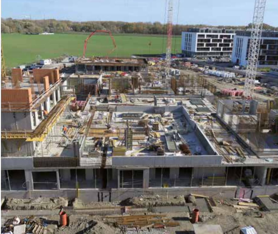
▲ Pohľad na rozostavaný objekt bytového domu.
