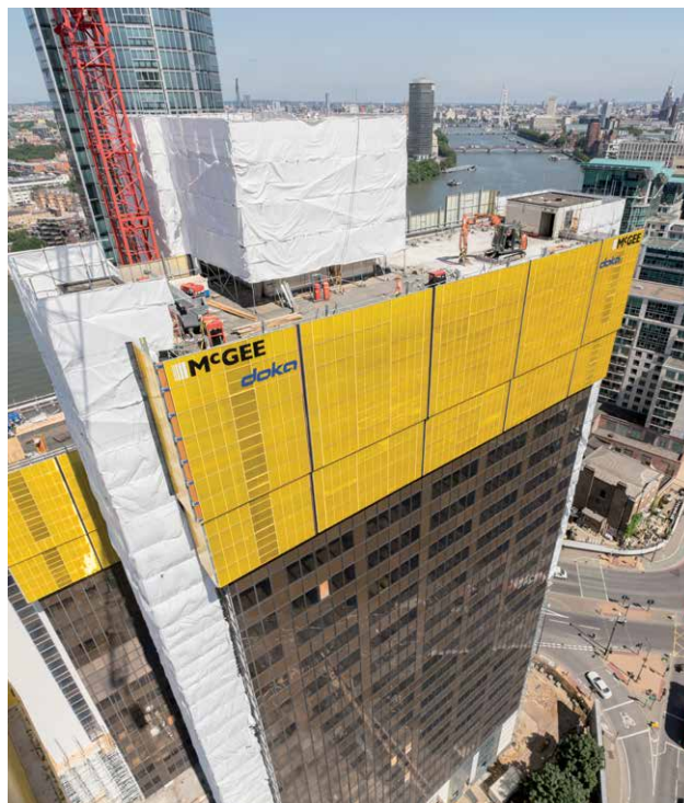
Nr. 1 Nine Elms, Londona, Apvienotā Karaliste | 89 m: automātiska lejupejoša kāpšana ar trokšņu slāpēšanas norobežojumu kontrolētiem nojaukšanas darbiem
