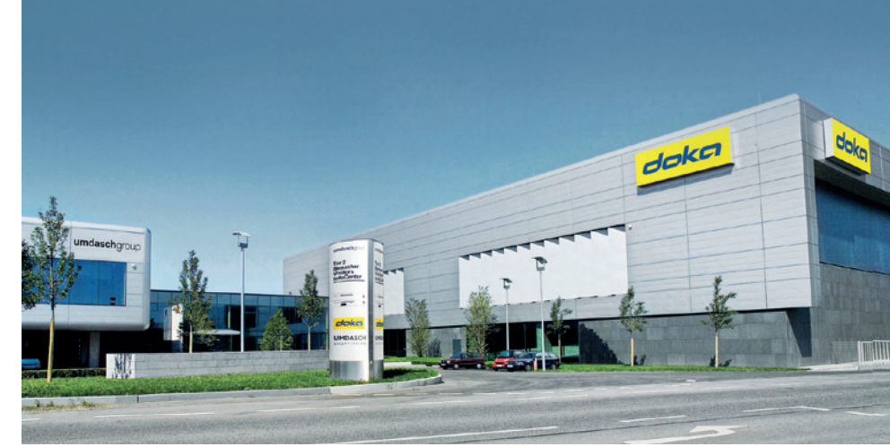
▲ Headquarter der Doka in Amstetten, Österreich
