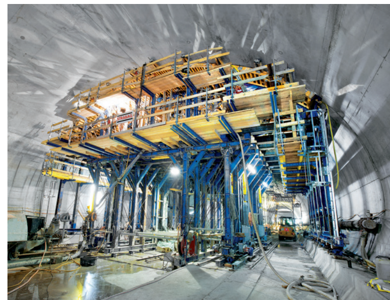
▶ Gotthard-Basistunnel Erstfeld, Schweiz
