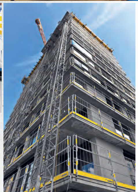
Sicherheit auf der Baustelle ▶ Professionell und sicher schalen
