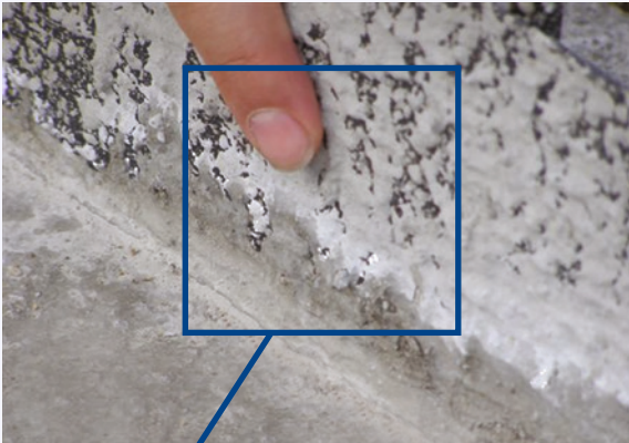
CEMflex VB: Die Kristallisation ist bereits sichtbar.
